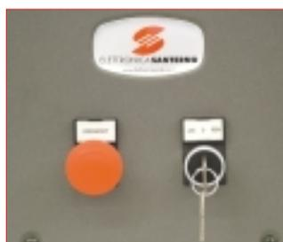
**LOCALE (LOC):** Permette di manovrare e regolare la velocità motore attraverso la tastiera dell'inverter (Start, Stop e Regolazione velocità)
